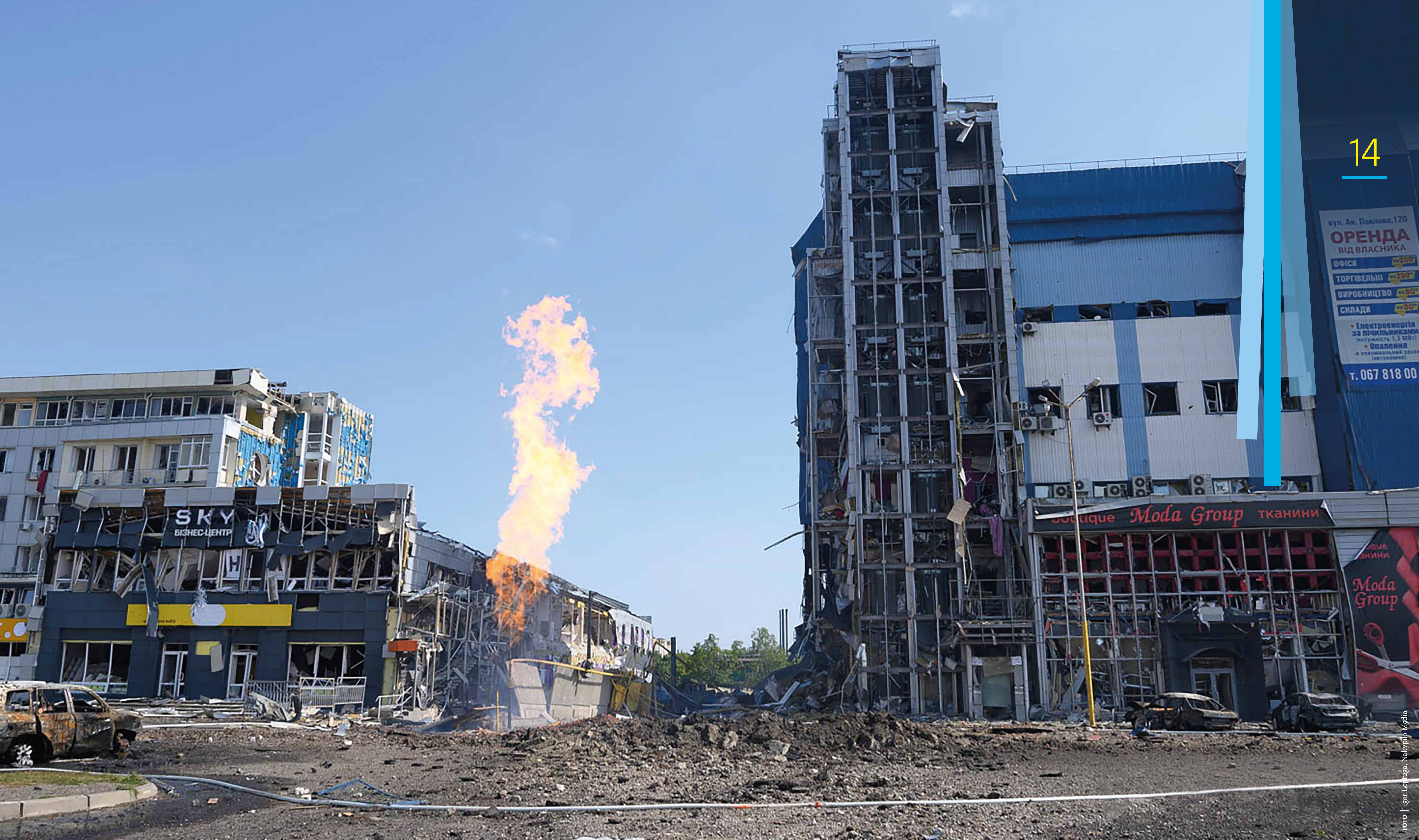
Kharkiv, 2024. Infrastruttura civile distrutta a seguito di un attacco aereo russo.
